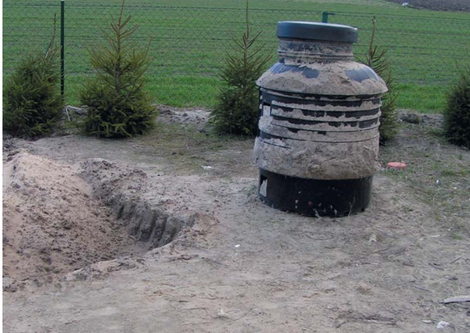
▲ Wykopana studzienka rozdzielcza
