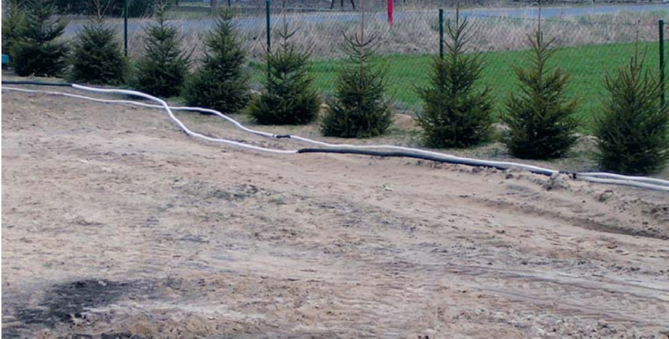
▲ Wyrwane rury instalacji dolnego źródła
