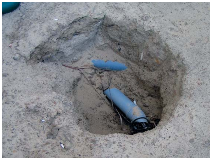
► Przecięta instalacja dolnego źródła
