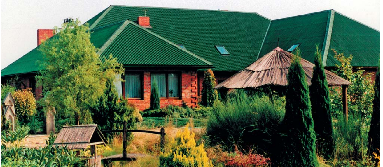
6 „Kolorowy” dach z płyt falistych (fot. Onduline) ▲
