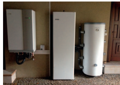
Fot 2. Instalacja powietrznej pompy ciepła NIBE SPLIT 16 kW w woj. łódzkim, wykonana przez firmę 4 ENERGY Tomika z Pabianic
