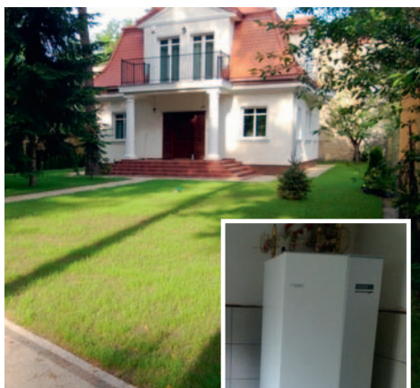
Fot 1. Instalacja gruntowej pompy ciepła NIBE F1245 8kW na Mazowszu, wykonana przez firmę PCM Klimat z Sulejówka
