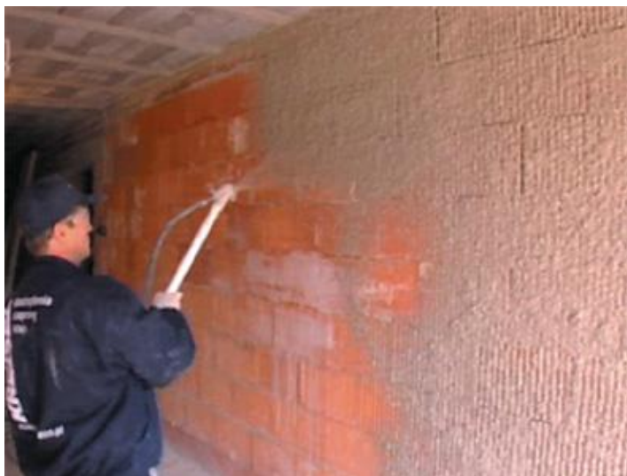
Fot. 11 W przypadku wykonywania tynków, masę tynkarską nanosi się na ściany i sufity przy użyciu aparatu (pistoletu) natryskowego. Czynność ta jest bardzo prosta. Wymaga jedynie zachowania mniej więcej stałej odległości dyszy od tynkowanej powierzchni. Należy pamiętać, aby przed rozpoczęciem tynkowania ściany i sufity zagruntować odpowiednim środkiem.
