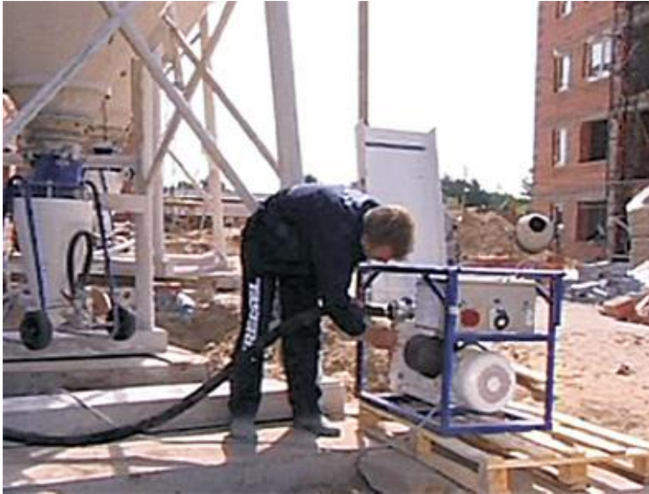
Fot. 7 Po ustawieniu silosu następuje montaż odpowiedniego do potrzeb systemu mieszająco-podającego. Może to być zestaw złożony z: - silomatu (sprężarki i zasobnika ciśnieniowego), agregatu tynkarskiego, aparatu natryskowego, węży doprowadzających materiał i sprężone powietrze oraz przewodów sterujących, - mieszarko-pompy do wylewek podłogowych, węża transportującego oraz pilota sterującego pracą pompy.
