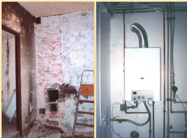
Czasami modernizacja instalacji grzewczej będzie wymagała remontu kotłowni (fot. archiwum BD)
