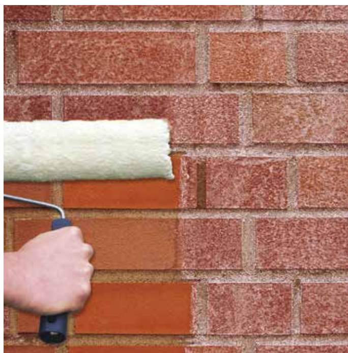
Podłoża chłonne. Impregnacja kremem
