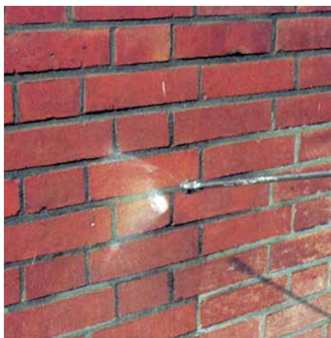
Podłoża mniej chłonne. Impregnacja preparatem płynnym
