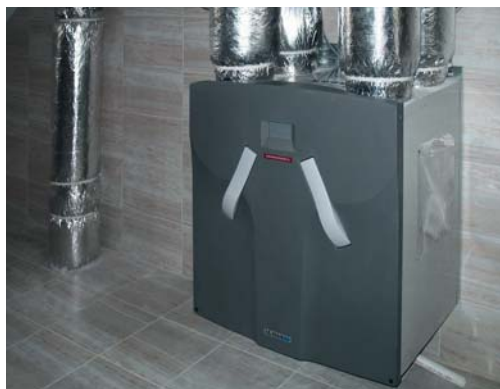
9 Nowoczesny rekuperator z wymiennikiem przeciwprądowym o sprawności 95%. Zalecany do instalowania w każdym dobrze ocieplonym domu, a nie tylko w energooszczędnym
