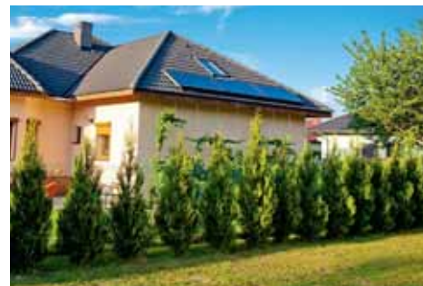
Rys.3 Kolektory słoneczne pozwalają na montaż w różnych warunkach. Zalecane jest zachowanie nachylenia 30 \pm 45^\circ oraz ustawienie w kierunku południowym z tolerancją \pm 45^\circ
