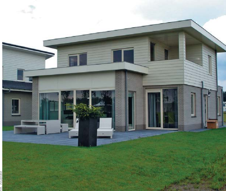
19 Panele z aluminium lub PVC – elementy osłonowe stosowane w metodzie lekkiej suchej
