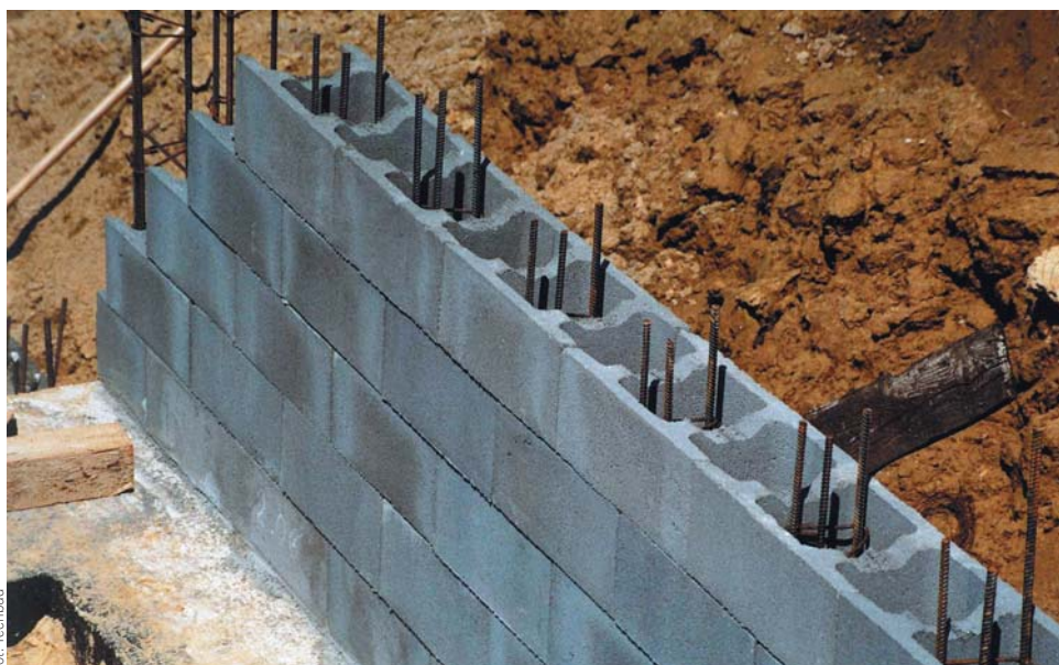
2 Ściany fundamentowe z pustaków zasypowych to jedno z najlepszych rozwiązań. Są uniwersalne dzięki możliwości zbrojenia i stosowania różnych betonów
