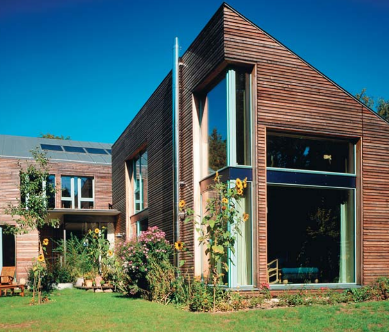
18 Elewacja z drewna jako atrakcyjny sposób zabezpieczenia termoizolacji
