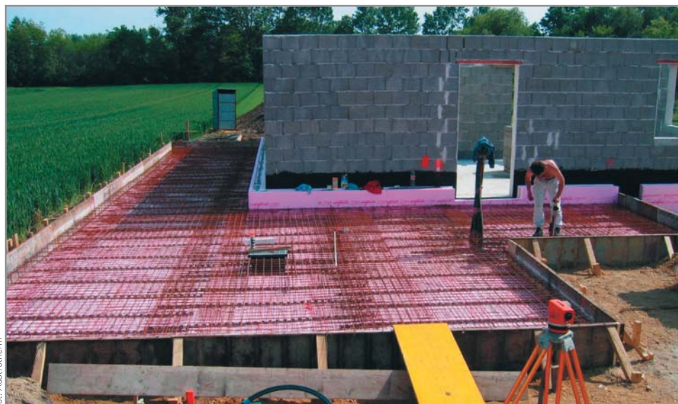
1 W domach jednorodzinnych z betonu monolitycznego wykonuje się ławy fundamentowe a czasami także płyty i ściany fundamentowe
