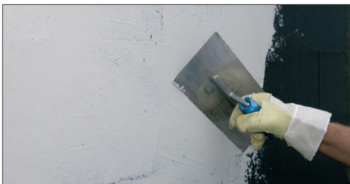
• Nanoszenie mineralnego mostka przyczepnego BOTAMENT® MD 28
