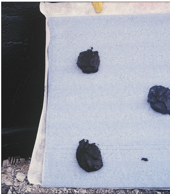
Płyta ochronno-drenażowa BOTAMENT® DS 993 chroni izolację przed uszkodzeniami mechanicznymi
