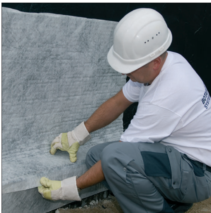
Płyta ochronno-drenażowa BOTAMENT® DS 993 chroni izolację przed uszkodzeniami mechanicznymi
