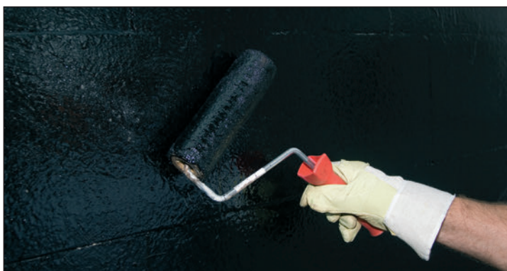
• Gruntowanie podłoża przy zastosowaniu BOTAMENT® B 97 L
