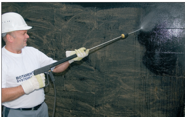
• Czyszczenie podłoża przy zastosowaniu urządzenia wysokociśnieniowego
