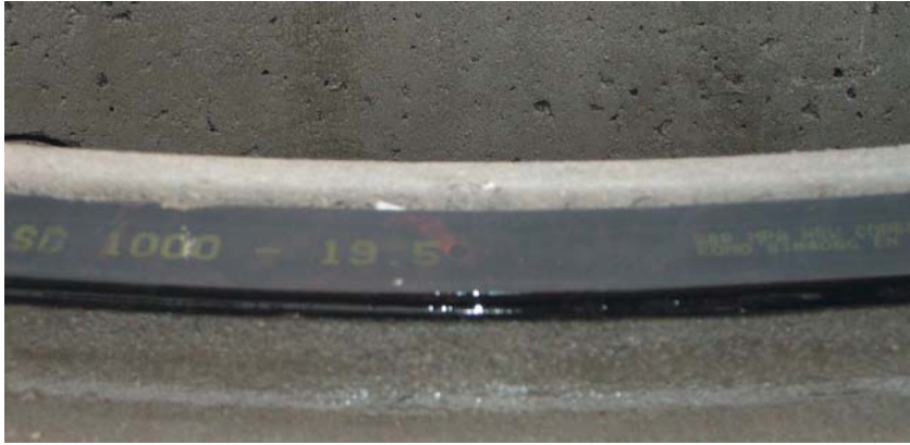
▲ Kręgi betonowe łączą specjalne uszczelki – gwarantujące pewne zespolenie systemów kanalizacji
