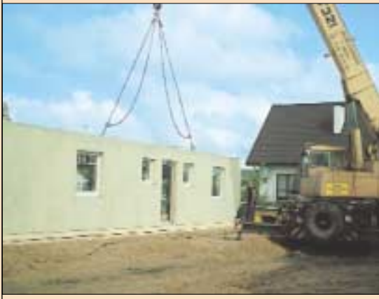
8 Budowa domu prefabrykowanego (fot. Finn Dom)
