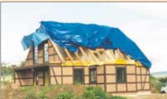
9 Prefabrykowany mur pruski (fot. Interhouse)
