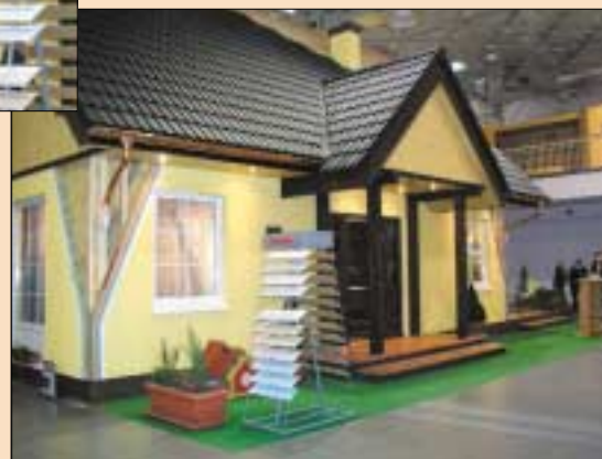
1 Dom szkieletowy (kanadyjski). Widoczna warstwowa budowa ścian (fot. Kronopol)
