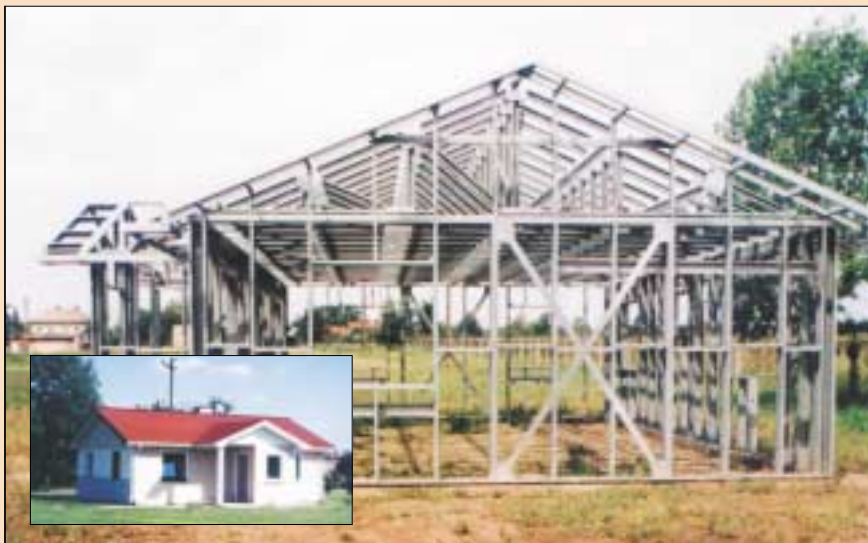
10 Dom zbudowany w oparciu o szkielet stalowy i widok samego szkieletu (fot. Amtech)
