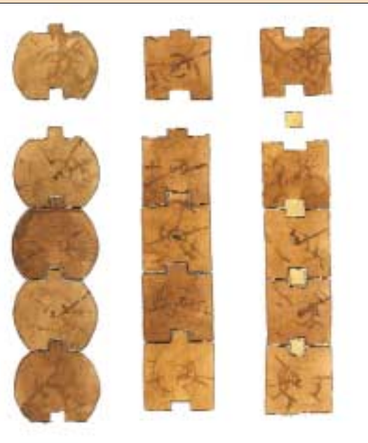
6 Odpowiednie wyprofilowanie bali ułatwia uszczelnienie ściany
