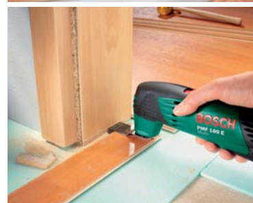
Przycinanie ościeżnicy stosownie do rodzaju i grubości panela oraz zastosowanych materiałów podkładowych
