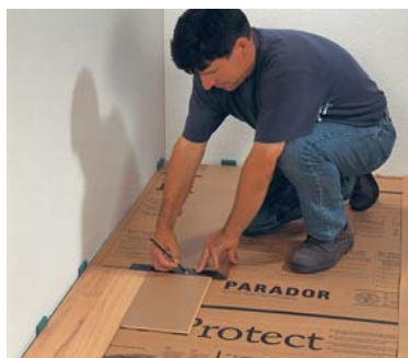
Wyznaczanie długości ostatniego panelu w rzędzie
