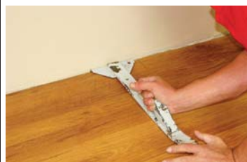
Układanie ostatniego rzędu paneli za pomocą żyłki stolarskiej
