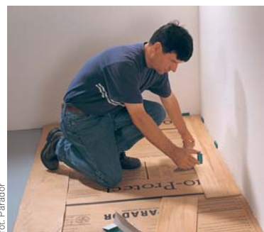
Tworzenie szczelin dylatacyjnych
