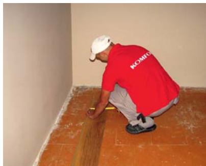
Mierzenie szerokości pomieszczenia i paneli
