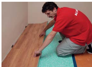
Opuszczanie rzędu paneli po usunięciu trójkątnych klinów
