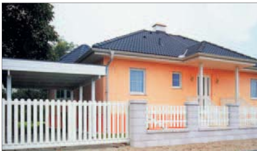
2 Przęsła ogrodzeniowe z aluminium (fot. OBA)
