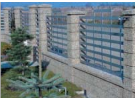
6 Słupki i podmurówka z betonu imitującego granit (fot. Styl-Bet)
