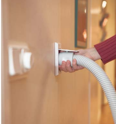
Najczęściej odkurzacz centralny włącza się, otwierając gniazdo i wkładając do niego wąż ssawny
