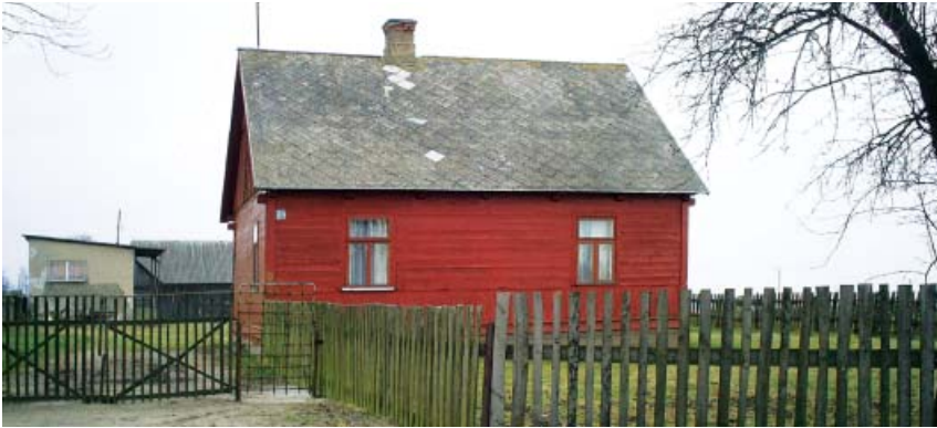
Można tak zadbać o drewnianą elewację, że trudno rozpoznać, czy dom jest stary, czy nowy, tu wiek zdradza sposób pokrycia dachu, oraz metoda łączenia desek. Początek XX wieku
