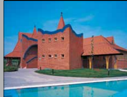
Krycie „w łuskę” „KERA-BIBER” z dachówką boczną ½ przesuwną
