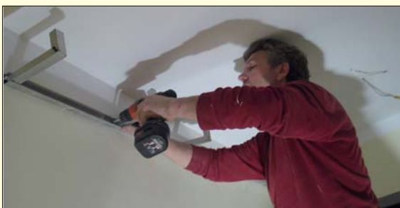
to miejsce usztywnij wkrętami WGB
