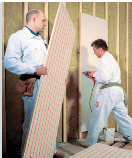
12 Montaż płyt g-k z zatopionymi w nich rurkami grzewczymi (fot. Variotherm)
