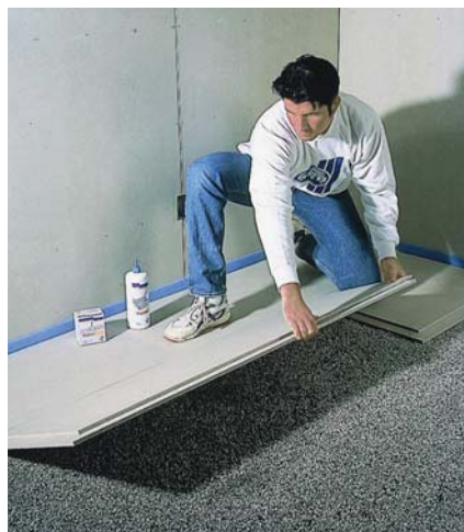
16 Układanie suchego jastrychu na odpowiednio przygotowanym podłożu – wyrównanym specjalną, suchą podsypką (fot. Rigips)
