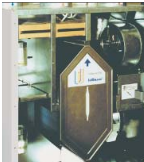
16 Rekuperator przeciwprądowy o budowie zwartej; strzałki na króćcach widocznych na górnej pokrywie wskazują kierunek i rodzaj powietrza
