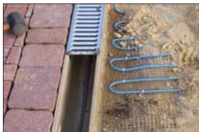
Ogrzewanie korytka odpływowego
