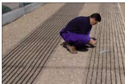
Montaż systemu ogrzewania przeciwbłodzeniowego podjazdu na pasach jezdnych
