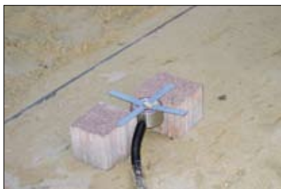
Sposób montażu czujnika śniegu/łodu i temperatury
