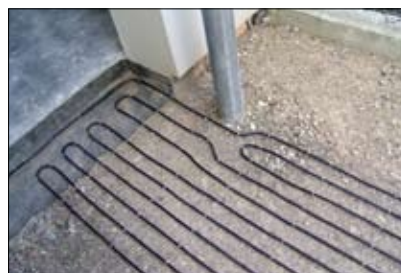
Sposób układania kabli na podjeździe
