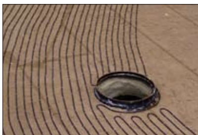
Ogrzewanie powierzchni zjazdu
