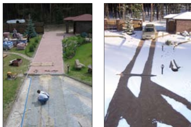
Ogrzewanie przeciwooblodzeniowe w trakcie montażu i efekt jego działania zimą.
