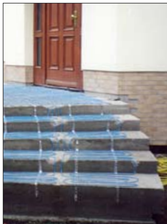
System ogrzewania przeciwblozeniowego na schodach
