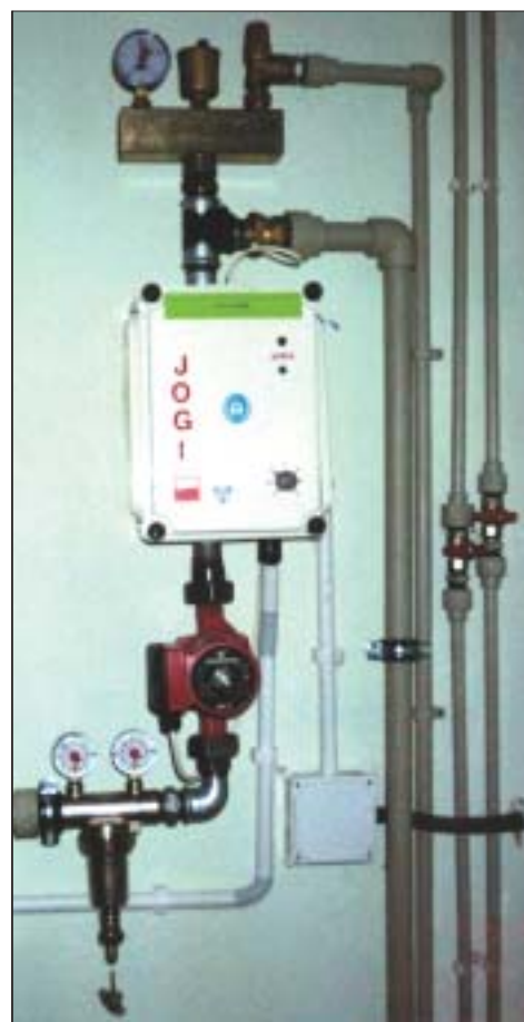
3 Elektroodowy kocioł grzewczy ma wysokość około 30 cm (fot. Yox-Pol)
