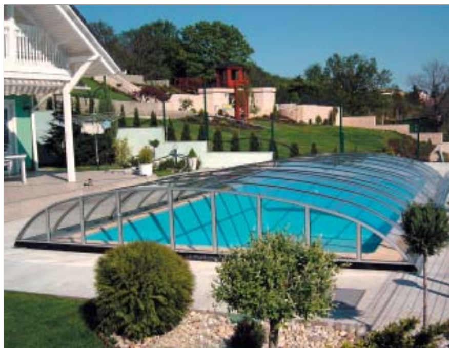
8 Zadaszenia wykonane z przezroczystych płyt z poliwęglanu zapobiegają skraplaniu się pary wodnej i nie ograniczają dostępu promieni słonecznych (fot. Alutherm)
