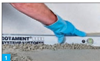
1 Wykonanie warstwy spadkowej przy zastosowaniu BOTAMENT® M 100 .
