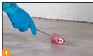
1 Gruntowanie podłoża środkiem BOTAMENT® D 11 .
