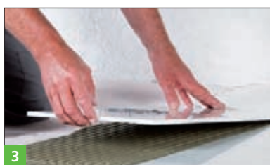
3 Staranne układanie płytki na łożę klejowe.
