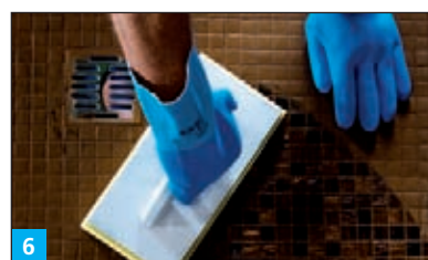
6 Zmywanie spoinowanej okładziny.
