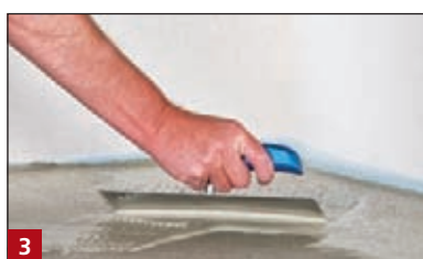
3 Nakładanie warstwy kontaktowej z BOTAMENT® M 25 Flex .
