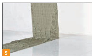
5 Kontrola podparcia płytki przez jej podniesienie.
