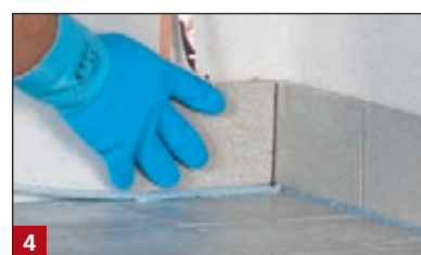
4 Wykonanie cokołu przy zastosowaniu BOTAMENT® TK 150.
