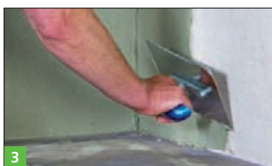
3 Szpachlowanie cienkowarstwowe wykonane z BOTAMENT® M 04 lub M 06.
