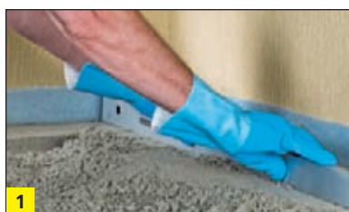
1 Wykonanie warstwy spadkowej (min. 2%) przy zastosowaniu BOTAMENT® M 100 .
