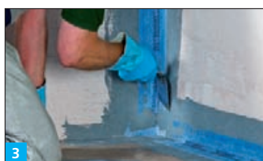
3 Układanie taśmy uszczelniającej BOTAMENT® SB 78 .
