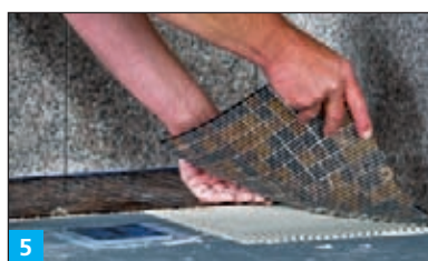
5 Układanie płytek ceramicznych na zaprawę BOTAMENT® M 21 , BOTAMENT® M 29 , BOTAMENT® M 12 Stone .
