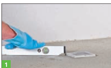
1 Wykonywanie spadku na posadzce przy zastosowaniu BOTAMENT® M 100.
