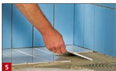
5 Układanie płytek w łożu klejowym BOTAMENT® M 22 metodą kombinowaną.
