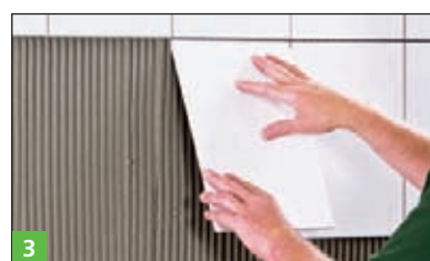
3 Układanie płytki na warstwę BOTAMENT® M 21 lub BOTAMENT® M 12 Stone .
