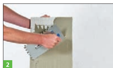
2 Nakładanie zaprawy BOTAMENT® M 29 lub BOTAMENT® M 12 Stone na podłóże oraz na spodnią powierzchnie płytki (tzw. metoda kombinowana).
