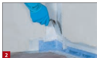
2 Wtapienie taśmy uszczelniającej BOTAMENT® SB 78 w narożnikach wewnętrznych.
