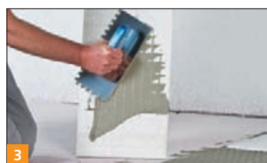
3 Nakładanie zaprawy MULTISTONE® na spodnią powierzchnię płytki.
