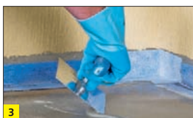
3 Wtapienie taśmy uszczelniającej BOTAMENT® SB 78 w narożnikach wewnętrznych, w warstwę BOTAMENT® MD 28 lub BOTAMENT® MD 1 .
