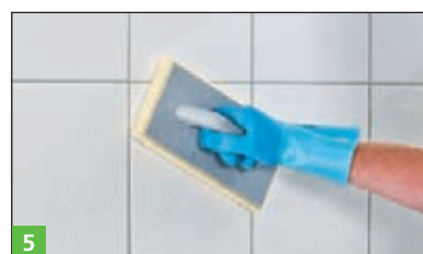
5 Formowanie oraz zmywanie spoiny.
