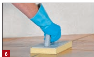
6 Zmywanie spoiny MULTIFUGE® lub BOTAMENT® CF 200 .
