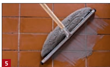
5 Spoinowanie okładziny zaprawą MULTIFUGE® lub BOTAMENT® CF 200 .
