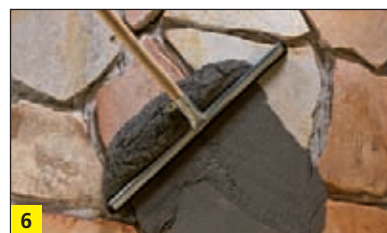
6 Spoinowanie okładziny przy zastosowaniu MULTIFUGE® .
