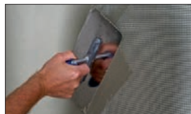
Alternatywnie w przypadku płyt budowlanych: w miejscach narażonych na uderzenia, aby uniknąć powstawania pęknięć, należy zastosować wzmocnienie z siatki z włókna szklanego.
