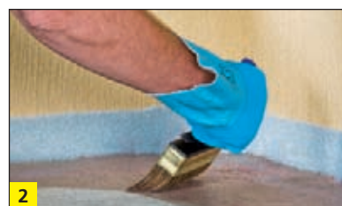
2 Gruntowanie warstwy spadkowej przy zastosowaniu BOTAMENT® D 11 .
