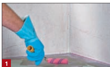
1 Gruntowanie powierzchni ściiennej i podłogowej przy zastosowaniu BOTAMENT® D 11.
