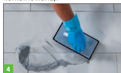
4 Spoinowanie zaprawą MULTIFUGE lub MULTIFUGE Schmal .
