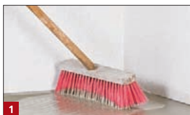
1 Nakładanie specjalnej zaprawy kontaktowej BOTAMENT® M 25 Flex jako mostek przyczepny.
