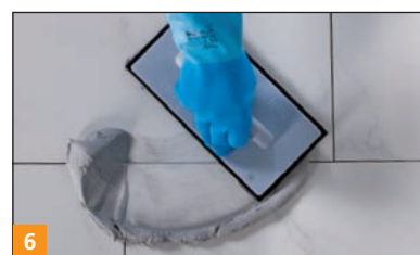
6 Spoinowanie wielkoformatowej okładziny zaprawą MULTIFUGE lub MULTIFUGE Schmal .
