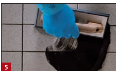
5 Spoinowanie zaprawą przewodzącą.
