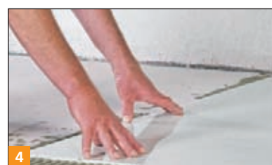
4 Staranne układanie płytki na łożo klejowe.
