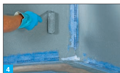
4 Nakładanie izolacyjnej folii w płynie BOTAMENT® DF 9 Plus , w dwóch warstwach (alternatywnie BOTAMENT® MD 1 ).
