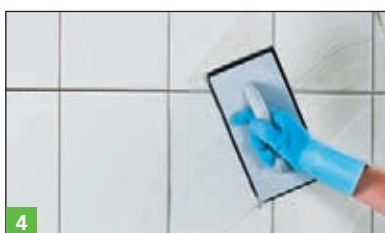
4 Spoinowanie zaprawą SUPAX® M 32 , MULTIFUGE® lub MULTIFUGE® Schmal .
