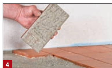
4 Układanie płytek na świeżym jastrychu na zaprawę kontaktową BOTAMENT® M 25 Flex .
