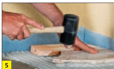
5 Układanie niekalibrowanego kamienia naturalnego na zaprawie BOTAMENT® M 12 Stone .
