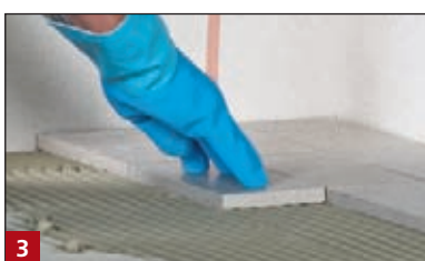
3 Układanie płytek przewodzących w łożu klejowym BOTAMENT® TK 150.
