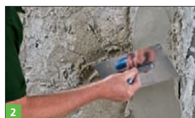
2 Obróbka BOTAMENT® M 100 na ścianie – grubość warstwy do 50 mm.
