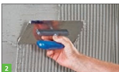
2 Nakładanie zaprawy BOTAMENT® M 21 lub BOTAMENT® M 12 Stone przy użyciu odpowiednio dobranej pacy zębatej.
