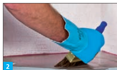
2 Gruntowanie warstwy spadkowej przy zastosowaniu BOTAMENT® D 11 .
