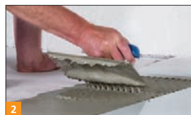
2 Nakładanie zaprawy klejowej do płytek BOTAMENT® PU 550 lub MULTISTONE® w konsystencji rozplývnej przy użyciu odpowiednio dobranej pacy zębatej.
