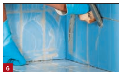
6 Spoinowanie okładziny zaprawą do spoinowania niecek basenowych BOTAMENT® S 250.
