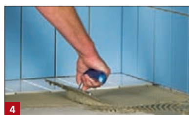
4 Nakładanie elastycznej zaprawy klejowej BOTAMENT® M 22 HP lub zaprawy klejowej o konsystencji rozplývnej BOTAMENT® M 29.
