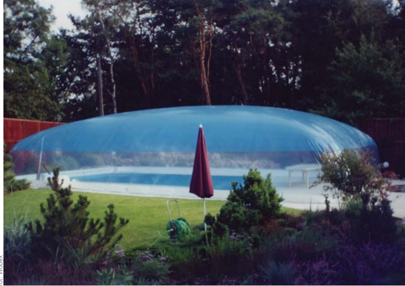
▲ Zadaszenie balonowe wykonane z grubej folii PVC. Jego zaletą jest to, że może być stosowane w basenach o nieregularnych i nietypowych kształtach
