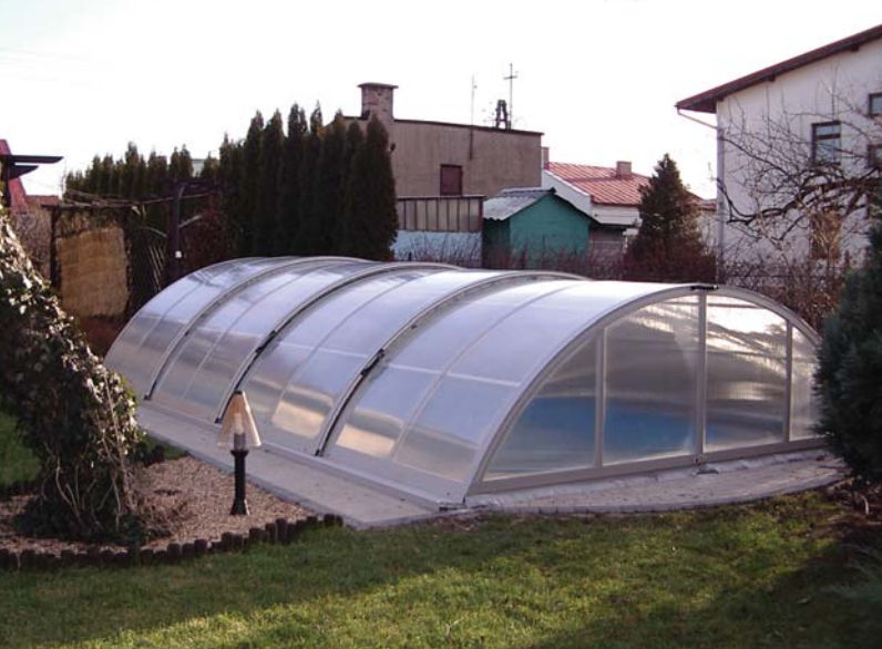
▲ Zadaszenie z konstrukcji aluminiowej wypełnionej płytami z poliwęglanu. Przesuwa się je teleskopowo po prowadnicach zamontowanych nad niecką basenu
