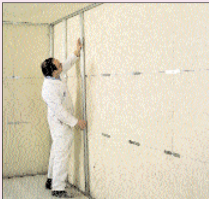
8 Stelaż metalowy musi być nierdzewny, gdyż gips powoduje korozję (fot. Rigips)
