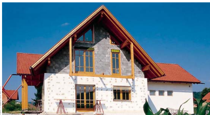
▲ Ściana dwuwarstwowa jest nieco mniej kłopotliwa w budowie, łatwiej też poprawić ewentualne błędy wykonawców
