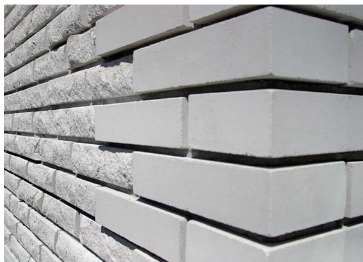
▲ Stosunkowo niedrogą ścianę trójwarstwową można wykonać z silikatów. Ciekawie może wyglądać połączenie cegieł gładkich i łupanych
