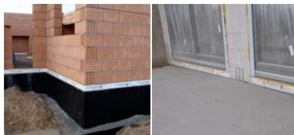
Fot. 1 Isomur jako cokół, Fot. 2 Isomur jako próg pod drzwi balkonowe lub tarasowe
