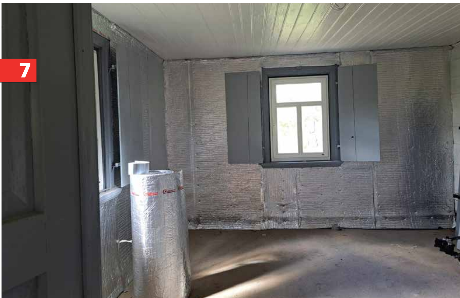
Przykładowa realizacja izolacji ścian w systemie wewnętrznym
