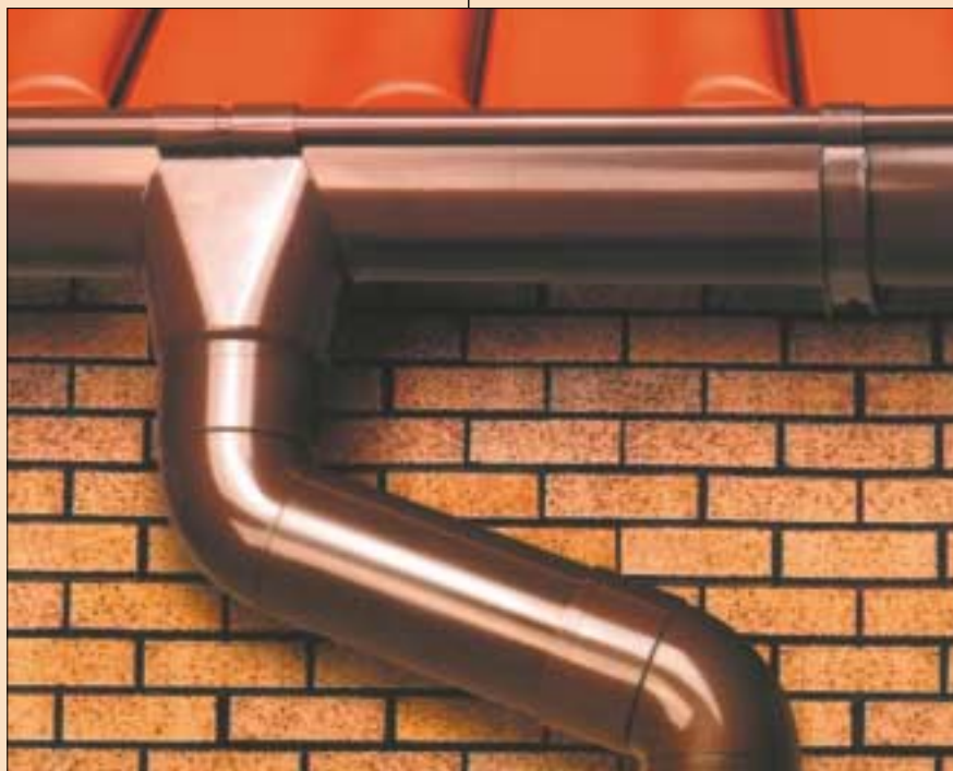
6 Rynny z powlekanej blachy połączone z rurami z PVC (fot. Galeco)
