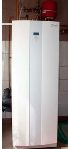
▲ Pompa ciepła Danfoss DHP-H 10 kW
