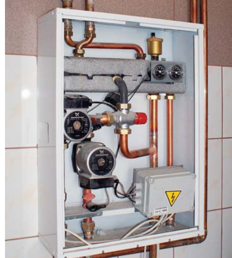
▲ Układ podmieszania, dzięki któremu ogrzewanie podłogowe i grzejniki „otrzymują” różne temperatury wody zasilającej
