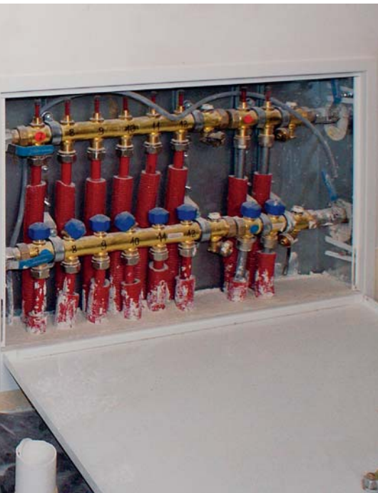
▲ Inwestycja 2 – jedna z dwóch szafek z rozdzielaczami na parterze. Sześć obwodów obsługuje ogrzewanie podłogowe, natomiast dwa grzejniki w łazienkach
