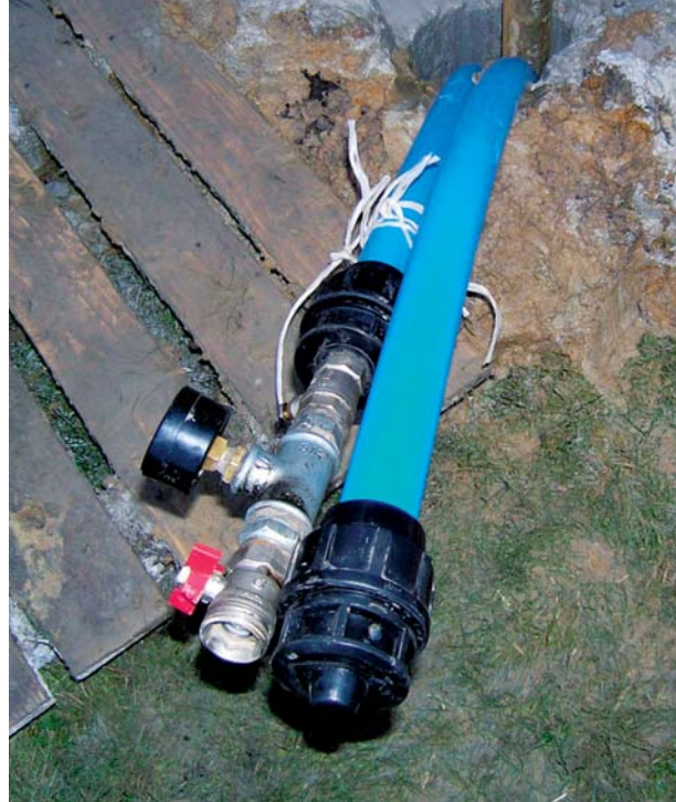
▲ Jeden z odwiertów pionowych z wystającymi końcówkami kolektora pionowego
