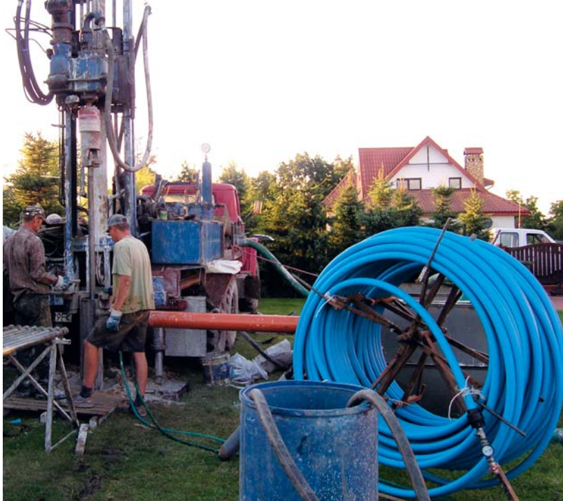
▲ Proces wiercenia otworów kolektora pionowego
