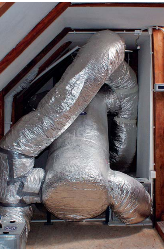
▼ Wentylacja na poddaszu nieużytkowym w domu w okolicach Hrubieszowa
