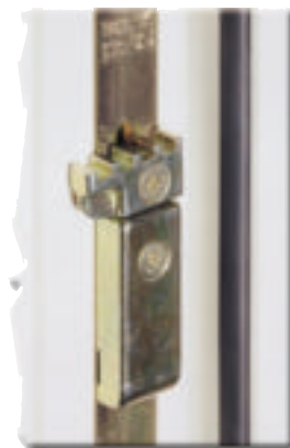
6 Okno uchylne, widoczny metalowy grzebień umożliwiający stopniowanie ustawienia skrzydła (fot. Sokółka)
