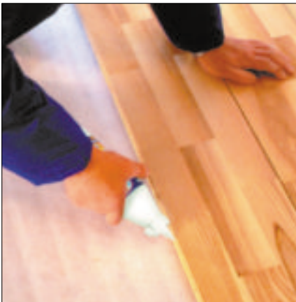
1 Klej do paneli nanosi się na ich krawędzie (fot. Śnieżka)
