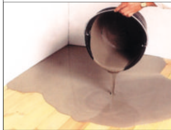
4 Masa wyrównująca stanowi dobry podkład pod nową posadzkę; można ją wylewać np. na istniejących deskach (fot. Mira)
