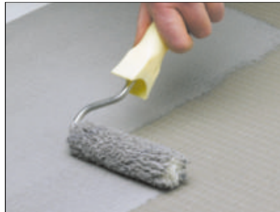
3 Izolację przeciwwilgociową z płynnej folii można układać na starych podłożach (fot. MC Bauchemie)
