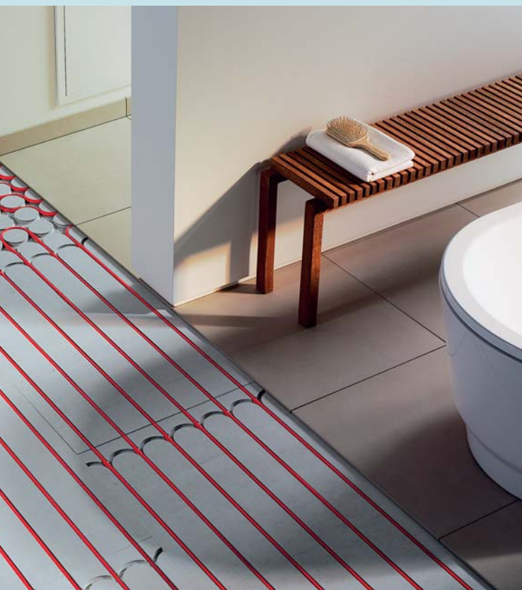
▲ Nowoczesny system wodnego ogrzewania podłogowego charakteryzuje się niewielką grubością podłogi
