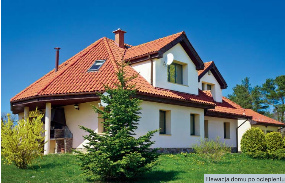
Elewacja domu po ociepleniu
