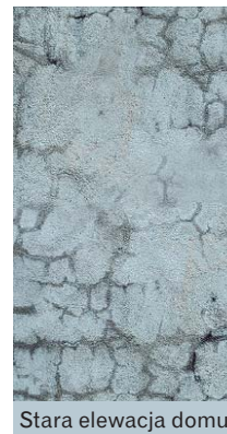
Stara elewacja domu
