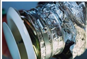
Na połączenie anemostatu z wewnętrzną rurą dystrybuującą nakłada się rękaw z wełny...
