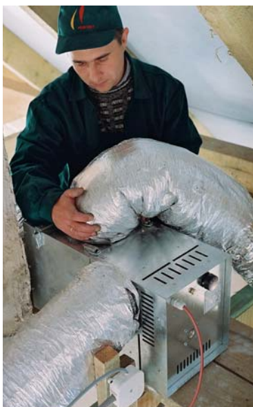
Wentylator zazwyczaj montuje się na strychu, poddaszu lub w okapie kominka z dostępem od tyłu. Przy takiej lokalizacji ogrzane powietrze zasysane jest jedną rurą zbiorczą z obudowy kominka i dopiero na wylocie z wentylatora montuje się rozdzielacz kierujący strumieniem powietrza do poszczególnych pomieszczeń.
