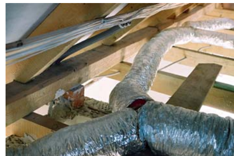
Rury dystrybuujące gorące powietrze można zaprowadzić także na belkach drewnianych w pomieszczeniu nieogrzewanym
