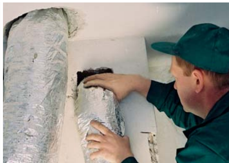
Wyprowadzenie rury dystrybuującej gorące powietrze przez strop
