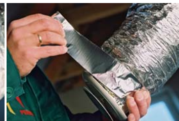
...i stabilizuje całość taśmą aluminiową
