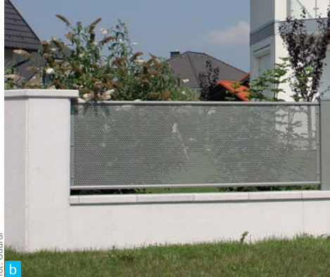
▲ Różnorodne pomysły na ogrodzenie: (a) słupki z bloków betonowych, a między nimi drewniane przęsła, (b) słupki murowane z cegieł otynkowane, przęsła wykonane z aluminium, (c) słupki betonowe pokryte cegłą klinkierową, wypełnienie – przęsła stalowe
