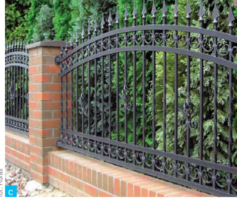
▲ Różnorodne pomysły na ogrodzenie: (a) słupki z bloków betonowych, a między nimi drewniane przęsła, (b) słupki murowane z cegieł otynkowane, przęsła wykonane z aluminium, (c) słupki betonowe pokryte cegłą klinkierową, wypełnienie – przęsła stalowe
