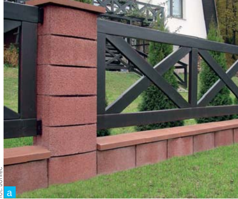
▲ Różnorodne pomysły na ogrodzenie: (a) słupki z bloków betonowych, a między nimi drewniane przęsła, (b) słupki murowane z cegieł otynkowane, przęsła wykonane z aluminium, (c) słupki betonowe pokryte cegłą klinkierową, wypełnienie – przęsła stalowe
