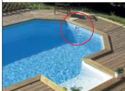
4 Skimer jest wbudowany w ściankę basenu (fot. Folkpool Polska)
