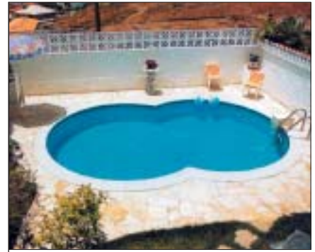
2 Basen z elementów stalowych (fot. Stefpool)
