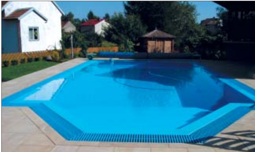
5 Basen z rynną przelewową; w głębi widoczna zwinięta plandeka (fot. Polder Technika Basenowa)
