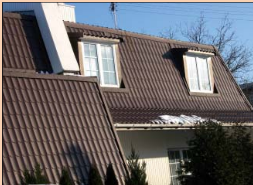
8 Stromy lecz prosty w formie dach mansardowy najłatwiej pokryć blachodachówką (fot. archiwum BD)
