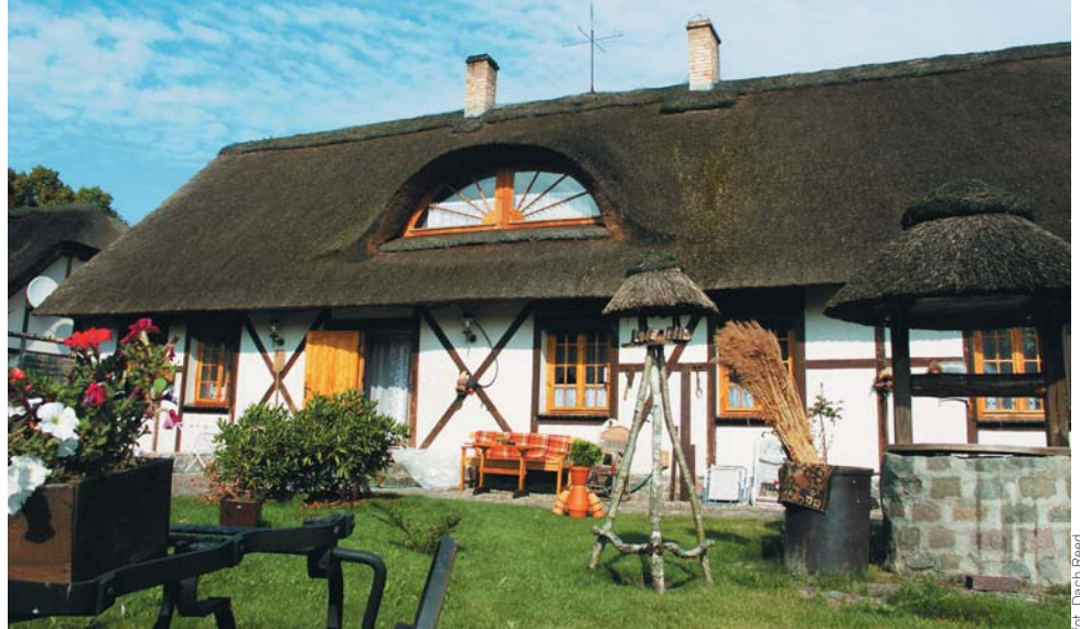
Krycie dachu strzechą to skomplikowana praca wymagająca sporych umiejętności i doświadczenia
