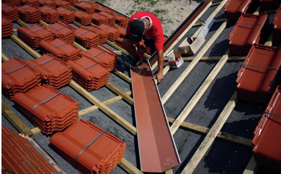
▲ Obróbka kosza musi być staranna, bo w tym miejscu ryzyko przecieku jest wyjątkowo duże
