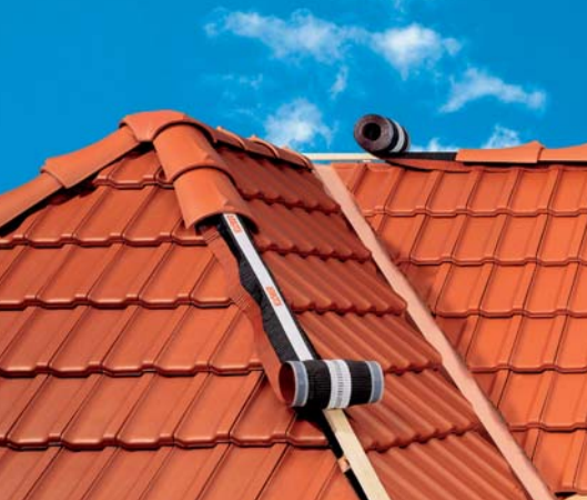
▲ Pod gąsiorami umieszcza się specjalne taśmy
