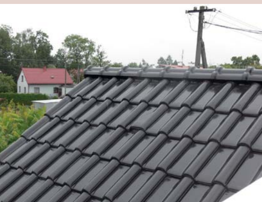
▲ Jedna z dachówek w drugim rzędzie umożliwia wentylację dachu
