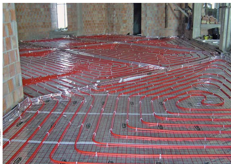
◀ ▼ Niskotemperaturowe ogrzewanie podłogowe najlepiej współpracuje z kotłem kondensacyjnym lub pompą ciepła
