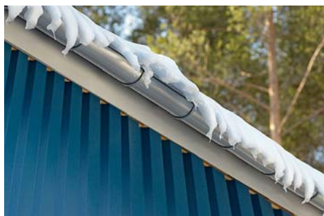
▲ Rynny stalowe wykazują dużą wytrzymałość mechaniczną, dlatego polecane są w miejscach o obfitych opadach śniegu
