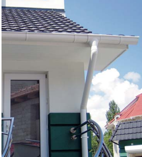
▲ Rynny z PVC w budynkach szczególnie narażonych na silne nasłonecznienie powinny być zaopatrzone w uszczelki EPDM i być w jasnym kolorze
