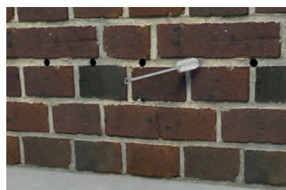
3. Czyszczenie otworów
