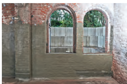
2. Wykonać wstępną izolację przeciwwodną
