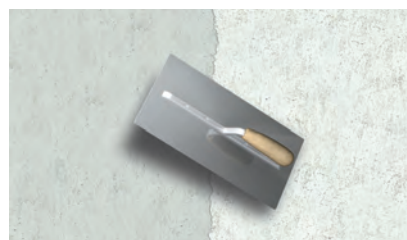
2. Naniesienie tynku renowacyjnego
