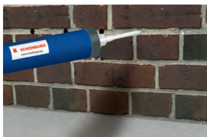
5. Wykonanie przepon poziomych (pasta)
