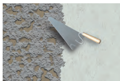
1. Naniesienie tynku podkładowego
