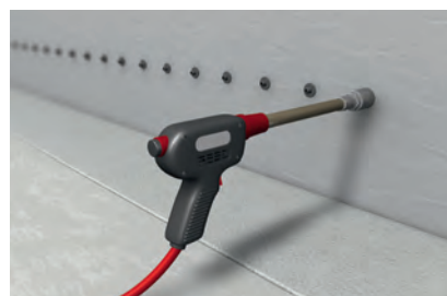
5. Wykonanie przepon poziomych (roztwór wodny)
