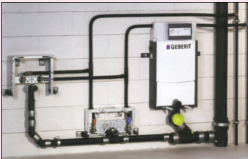
2 Do różnych urządzeń sanitarnych są różne stelaże instalacyjne: patrząc od lewej pierwszy jest do umywalki, drugi - bidetu, trzeci - miski ustępowej (fot. Geberit)
