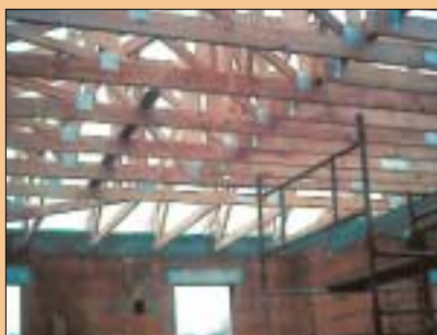
Elementy więźby łączone płytkami kolczastymi (fot. Eraga)
