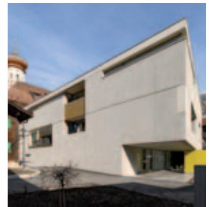
Bank Raiffeisen, Schruns, Vorarlberg, Austria (Lang & Vonier Architekten, Göfis)
