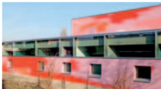
Siedmiokolorowa elewacja z tynku zatartego mechanicznie łączy stare i nowe.
