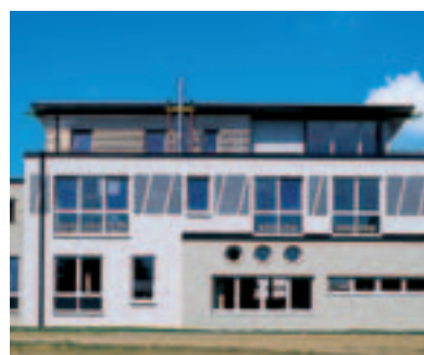
Zakład malarski Federlechner, Karlsruhe, Niemcy (Winkler + Bahm Architekten)
