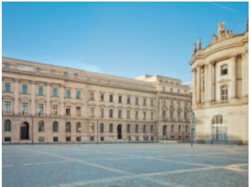
Renowacja hotelu Opern Carreé, Berlin-Mitte, Niemcy - StoTherm Mineral (Renowacja: Aukett + Heese)
