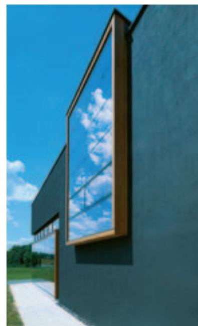
Budynek firmy Steybe, Weinstadt-Endersbach, Niemcy (Fuchs, Wacker Architekten BDA, Stuttgart, Niemcy) System ociepleniowy StoTherm Classic L)
