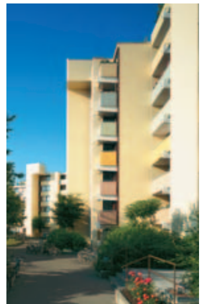
Renowacja budynku mieszkalnego, Prof. Angermair Ring, Garching, Niemcy – StoTherm Reno (Karl)
