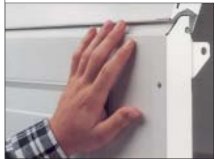
5 Specjalny kształt krawędzi segmentów chroni palce przed przytraśnięciem (fot. Gadip)
