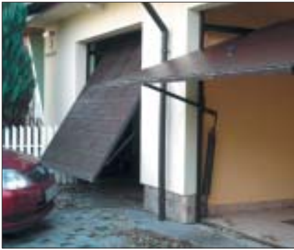
1 Bramy uchylne – płyta pancierza podnosi się do góry (fot. Wimar)
