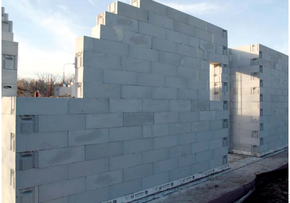
▲ Dom energooszczędny budowany w technologii ścian dwuwarstwowych: z bloczków betonu komórkowego YTONG grubości 24 cm, ocieplonych 20 cm warstwą wełny skalnej
