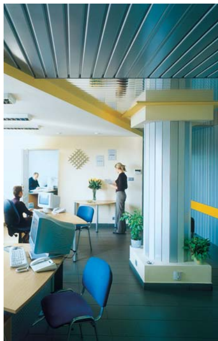
6 Sufity ze stalowych paneli na razie dominują w biurach (fot. Punto) ▲
