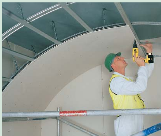
Łukowy sufit wykonuje się z elastycznych płyt g-k (fot. Rigips)
