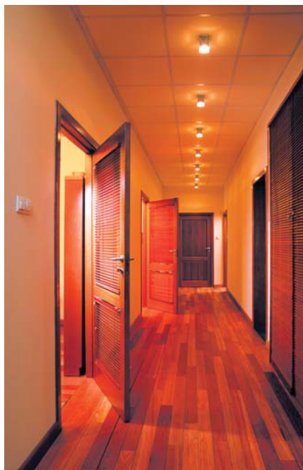
5 Kasetony ułatwiają dostanie się do przestrzeni nad sufitem (fot. DLH Drewno) ▲
